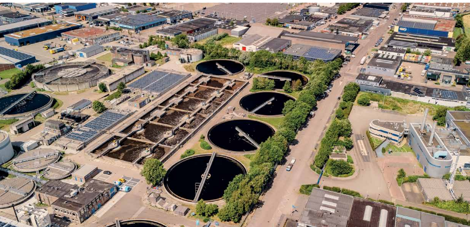
RIOOLWATERZUIVERINGSINSTALLATIE IN BEVERWIJK | Foto: Terence Loos
