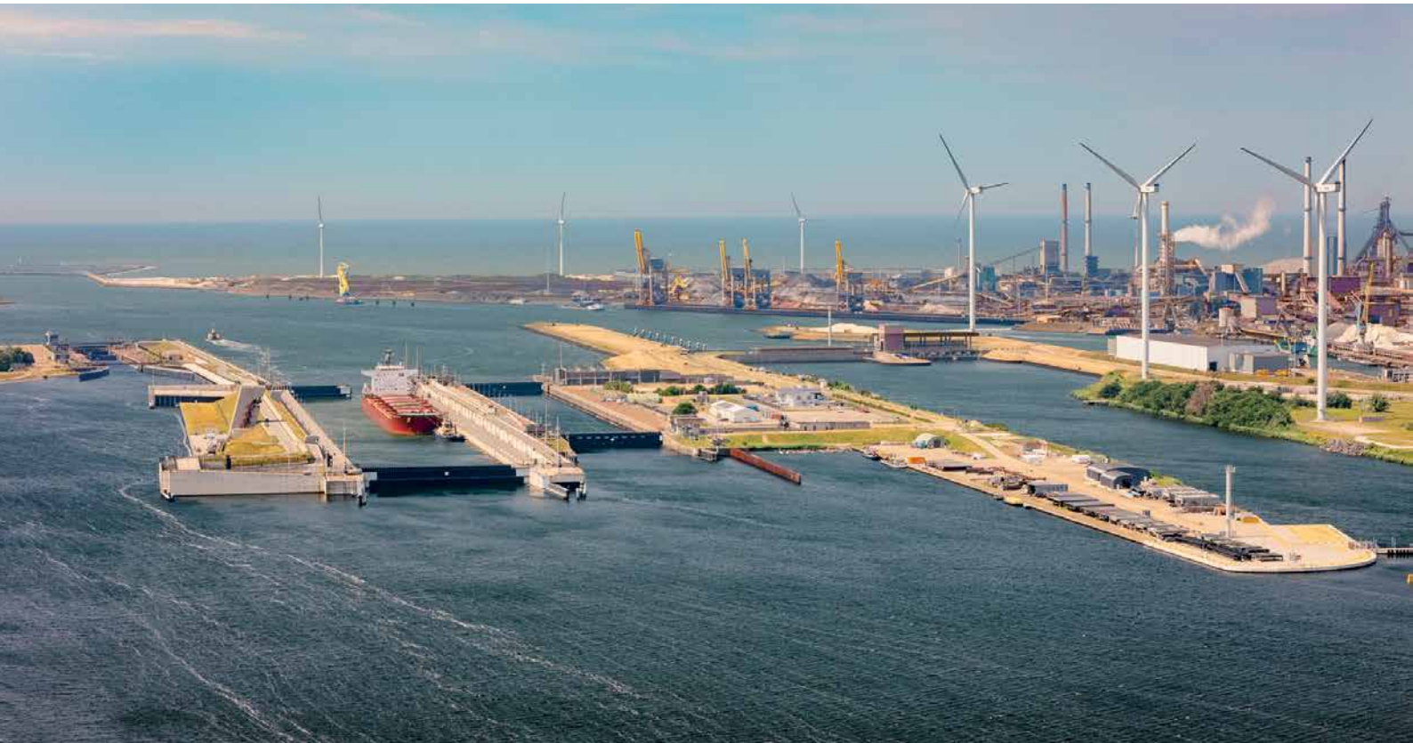
LUCHTFOTO SLUIZENCOMPLEX IN IJMUIDEN | Foto: Terence Loos
